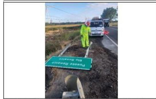
Ilustración N°3: Reposición de Señalización Ruta 180
