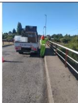
Ilustración N°6: Limpieza de Cunetas Ruta 180
