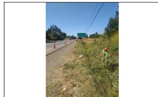
Ilustración N°4 Limpieza de Fosos en Ruta 180
