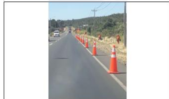
Ilustración N°2: Roce y Despeje de Faja Ruta 180
