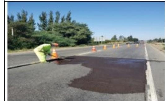
Ilustración N°3: Colocación Sello Bituminoso Ruta 180
