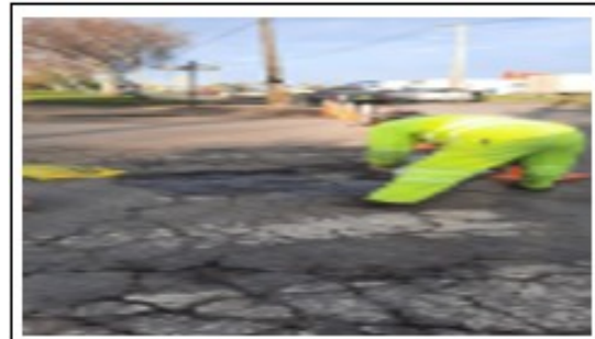
Ilustración N°1: Sellado de Grietas y Bacheo Ruta 180
