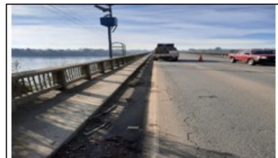
Ilustración N°3: Limpieza de Cunetas Ruta 180
