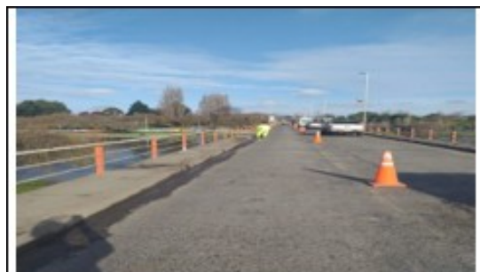
Ilustración N°4 Limpieza de Cunetas Ruta 180
