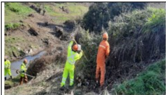
Ilustración N°1: Limpieza de Ladera Puente Itraque Ruta 180
