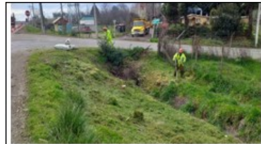
Ilustración N°3: Limpieza de Foso Ruta 180
