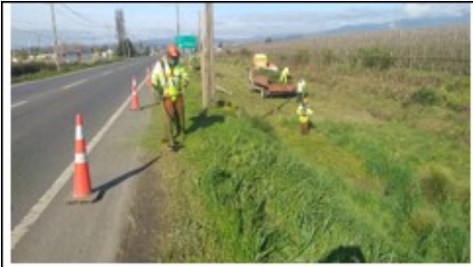
Ilustración N°8: Limpieza de Faja Ruta 180
