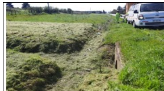
Ilustración N°5: Limpieza de Alcantarillas Ruta 180
