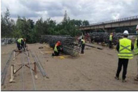
Ilustración N°5: Armadura para Pilotes Puente Coihue
