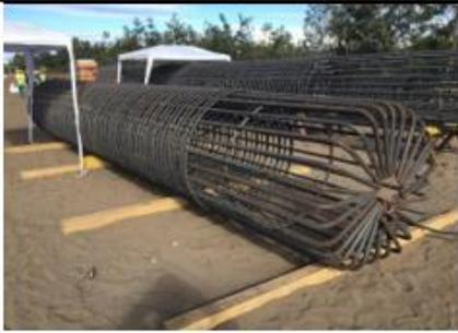
Ilustración N°6: Armadura para Pilotes Puente Coihue
