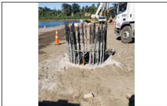
Ilustración N°2: Pilotes Pre-excavados in Situ Puente Coihue
