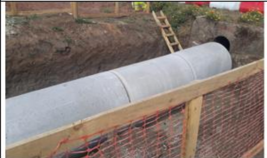
Ilustración N°4 Instalación de Tubos OAT Ruta 180
