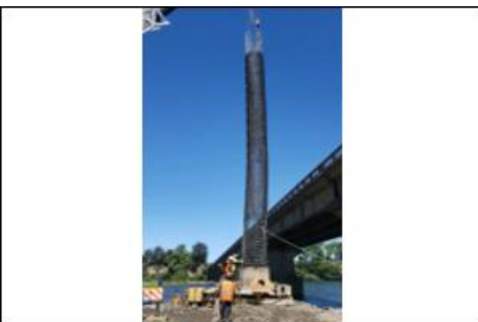
Ilustración N°6: Armadura para Pilotes Puente Coihue
