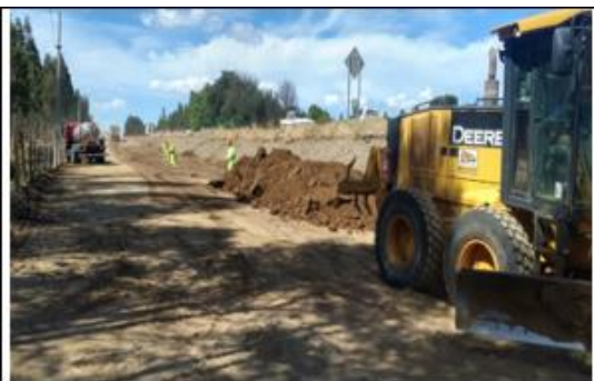
Ilustración N°5: Formación y Compactación de Terraplén Ruta 180
