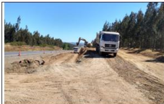
Ilustración N°3: Formación y Compactación de Terraplén Ruta 180
