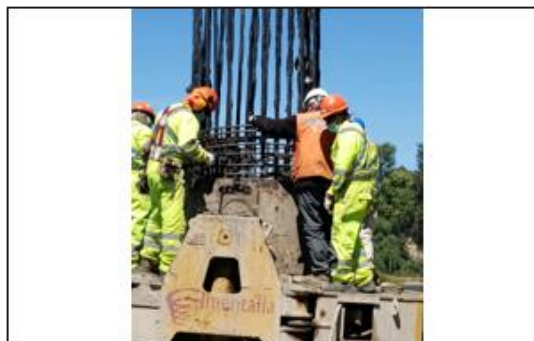
Ilustración N°1: Pilotes Pre-excavados in Situ Puente Coihue
