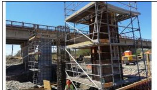
Ilustración N°2: Enfierraduras pilares Puente Coihue
