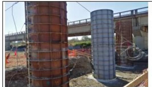
Ilustración N°1: Hormigonado Pilares Puente Coihue
