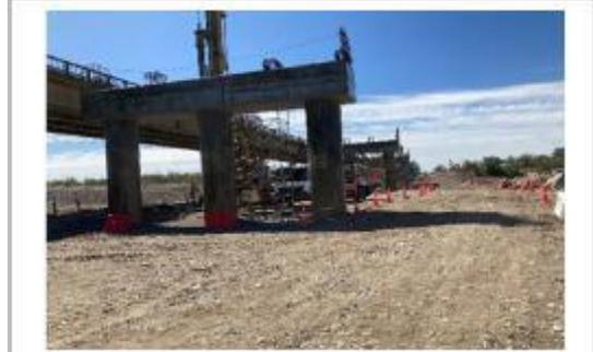
Ilustración N°4 Viga Cabezal Puente Coihue
