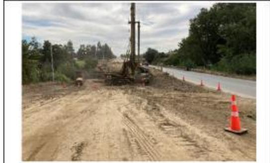
Ilustración N°6: Pilotes Preexcavados Puente Itraque
