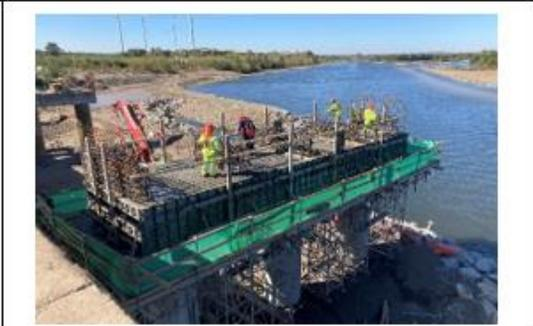
Ilustración N°2: Viga Cabezal Cepa N°10 Puente Coihue
