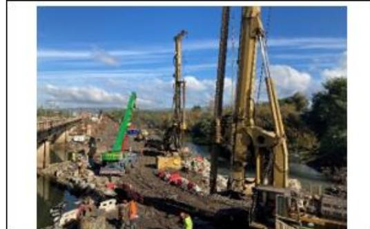
Ilustración N°4 Pilotes Preexcavados Puente Malleco
