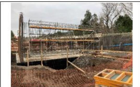
Ilustración N°3: Estribo Salida Puente Itaque
