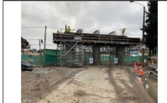
Ilustración N°6: Viga Cabezal Cepa 1 PS Huequén
