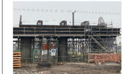
Ilustración N°5: Armadura Viga Cabezal Cepa 2 PS Huequén
