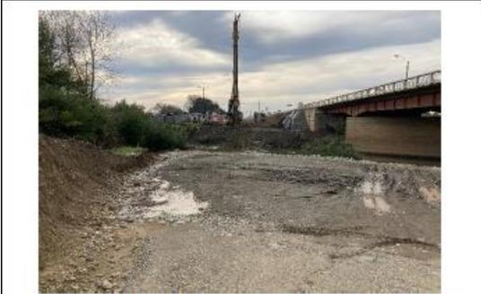
Ilustración N°2: Pilotes Preexcavados Puente Huequén
