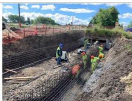
Ilustración N°6: Armadura Losa Canal Buenos Aires
