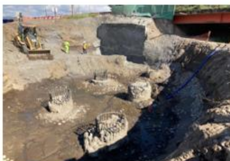
Ilustración N°2: Fundación ES Puente La Suerte
