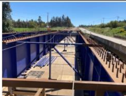
Ilustración N°5: Vigas Puente Itraque.
