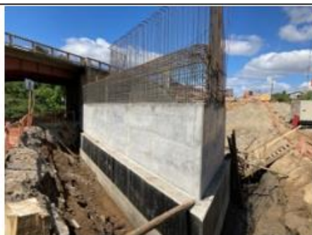
Ilustración N°3: Estribo Salida Puente Huequén
