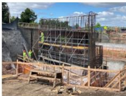
Ilustración N°4 Estribo Entrada Puente Huequén
