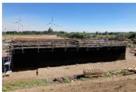
Ilustración N°3: Muros Paso Superior Roblería
