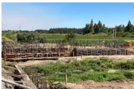
Ilustración N°2: Estribo Puente Pichirenaico CI - CD
