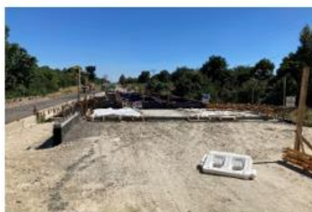
Ilustración N°4 Losas Acceso Puente Itraque
