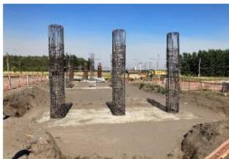
Ilustración N°1: Columnas Paso Inferior Santa Amelia
