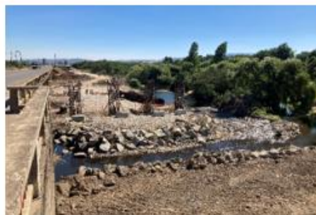
Ilustración N°5: Columnas Cepa 1 Puente Malleco
