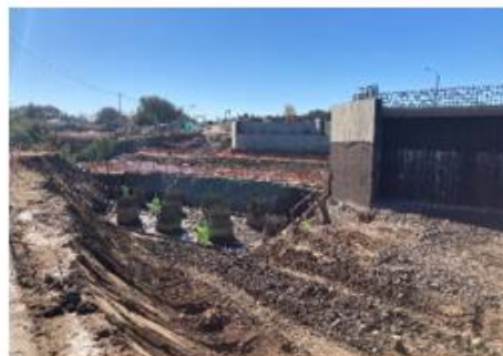
Ilustración N°6: Pilote Estribo Salida Puente Huequén
