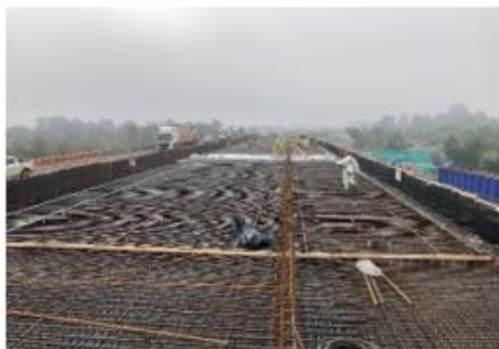
Ilustración N°1: Armadura Losa Tablero Puente Caihue
