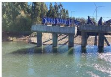
Ilustración N°4 Vigas Puente Renaico
