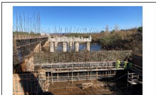
Ilustración N°2: Muro Estribo Entrada Puente Malleco
