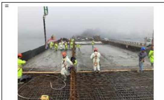
Ilustración N°1: Hormigón Losa Tablero Puente Caihue
