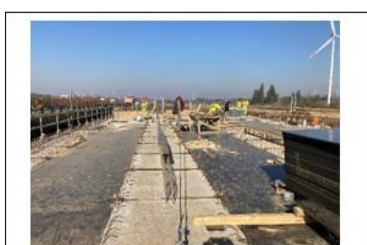
Ilustración N°6: Moldaje Losa Tablero Puente Pichirenaico
