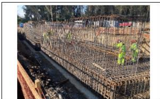
Ilustración N°3: Armadura Fundación Estribo Salida Puente Renaico Calzada Derecha e Izquierda
