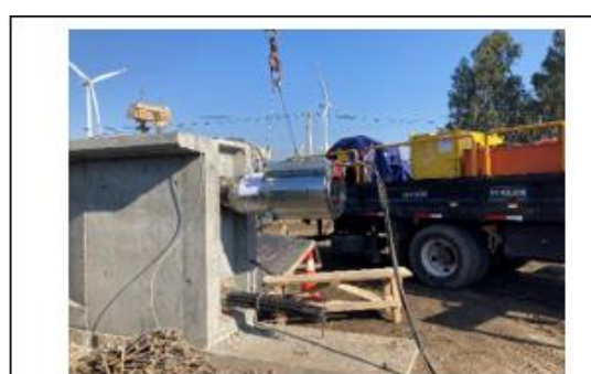
Ilustración N°5: Postensado Vigas Puente Pichirenaico
