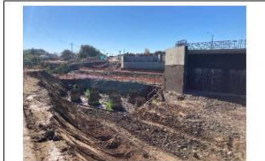
Ilustración N°4 Fundación Estribo Salida Puente Huequén Calle de Servicio
