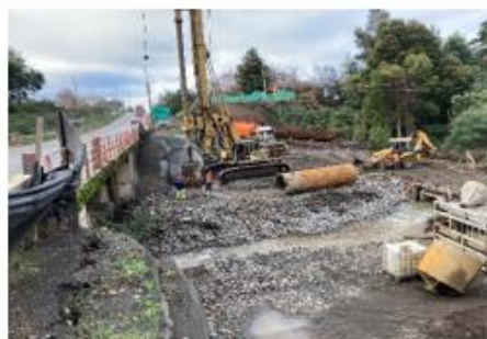
Ilustración N°5: Pilotes Estribo Entrada Puente Coyanco
