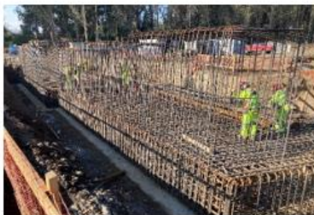
Ilustración N°2: 4 Estribo Salida puente Renaico CI-CD
