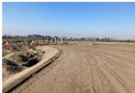
Ilustración N°6: Terraplén Variante Renaico
