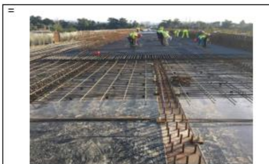
Ilustración N°1: Armadura Losa Tablero Puente Caihue Tramo 1
