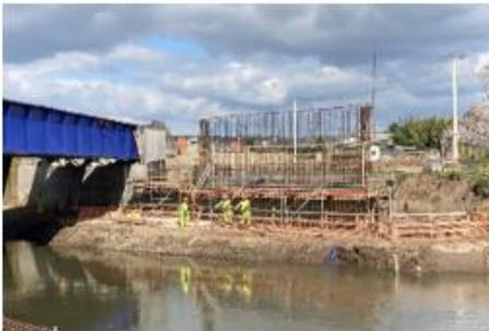
**Ilustración N°2: Estribo Salida Puente Huequén CS**
