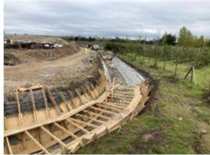
**Ilustración N°2: Revestimiento Canal Coihue**
