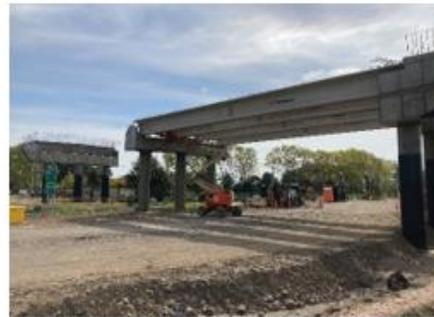
**Ilustración N°4 Paso Inferior Enlace Coihue Montaje Vigas Pretensadas**
