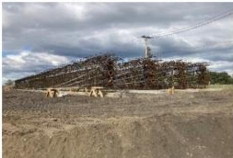
**Ilustración N°3: Armadura Vigas Postensadas Paso Superior Viaducto Coihue**
