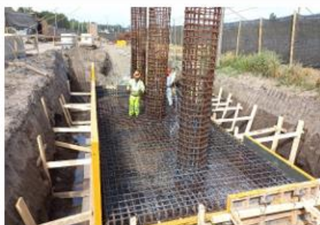
Ilustración N°6: Fundación y Columna Estribo Salida Sur Enlace Los Angeles - Ruta 5
