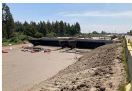
Ilustración N°5: Relleno Estribo Salida Puente Pichirenaico Calzada Izquierda y Derecha
