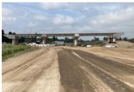
Ilustración N°3: Paso Inferior Enlace Renaico Sur
