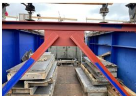
Ilustración N°4 Arriostramiento Vigas Puente Renaico
