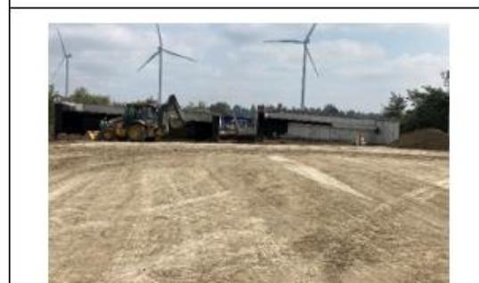
**Ilustración N°6: Relleno Estructural y Terraplén Estribo Salida Puente Renaico Calzada derecha e Izquierda**
