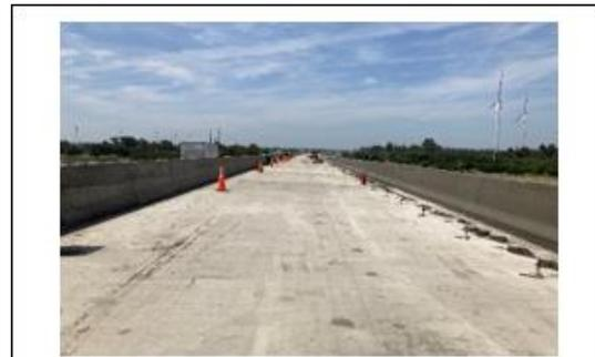
**Ilustración N°2: Defensa tipo F Hormigón Puente Caihue Tramo 1**
