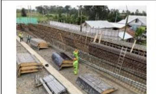
**Ilustración N°5: Armadura Vigas Postensadas Viaducto Caihue**
