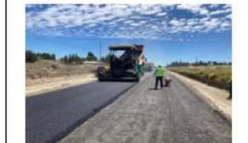
**Ilustración N°6: Colocación caps Asfalto tipo Binder Eje 1 tramo B**
