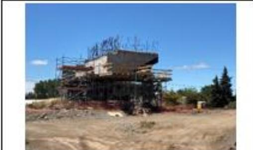
**Ilustración N°3: Ectribo Salida Paso Inferior Ovejería**
