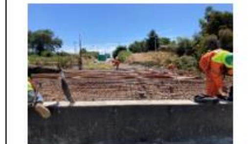
**Ilustración N°4 Armadura Local Tablero Puente**
