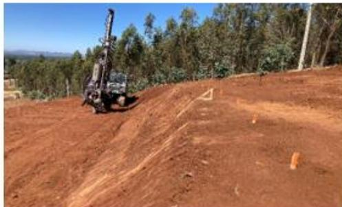
**Ilustración N°5: Reforzamiento de talud sector Enlace Las Perdices**
