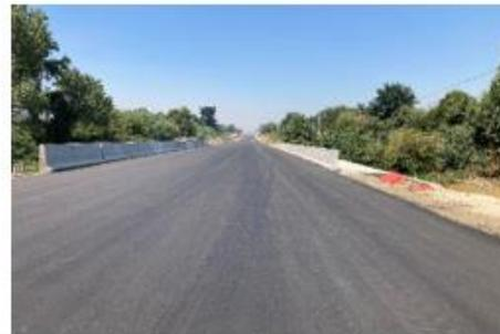
**Ilustración N°6: Colocación capa Asfalto tipo Carpeta Eje 1 tramo B Puente Itraque**
