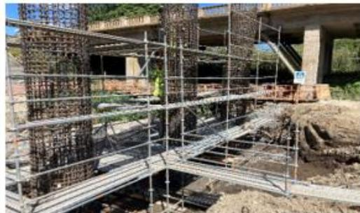
**Ilustración N°3: Armadura Cepa puente Tijeral Calzada Izquierda**
