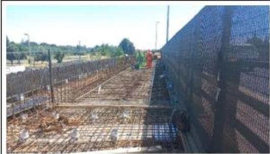
**Ilustración N°1: Paso Superior Ruta Armadura Losa Tablero lado sur**
