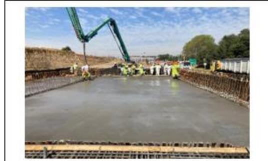
**Ilustración N°2: Losa Tablero Tramo 16 Puente Coihue**
