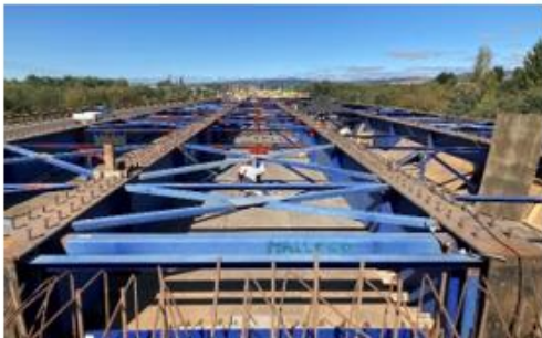
Ilustración N°3: Puente Malleco Arriostramiento Vigas
