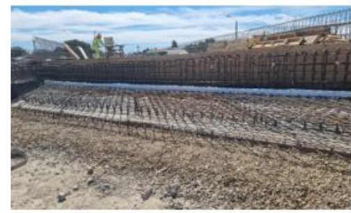
Ilustración N°4 Puente Huequén Calzada Derecha Losa de Acceso
