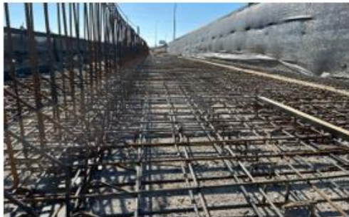
Ilustración N°1: Armadura Losa Tablero Paso Superior Ruta 5 lado norte
