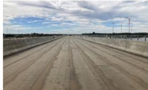
Ilustración N°2: Puente Coihue Impermeabilización Losa Tablero Tramo 2
