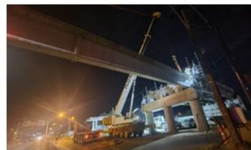
Ilustración N°6 Paso Superior Huequén Montaje Viga Postensada
