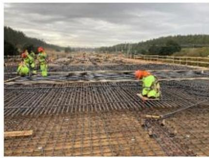
**Ilustración N°2: Armadura Losa Tablero Puento Malleco**
