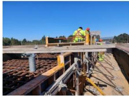
**Ilustración N°4 Cabezal N°3 Paso Superior Viaducto Coihue**
