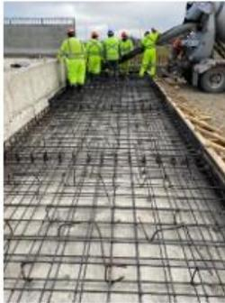
**Ilustración N°3: Losa Acceso Puente Renaico Calzada Derecha**
