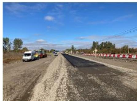
**Ilustración N°6 Colocación Mezcla Asfáltica tipo Binder**
