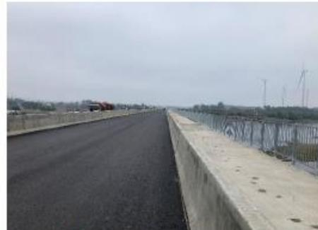
**Ilustración N°4 Puente Coihue con Carpeta Asfáltica**
