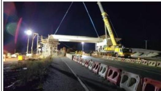
**Ilustración N°6 Montaje Vigas Paso Inferior La Paz**
