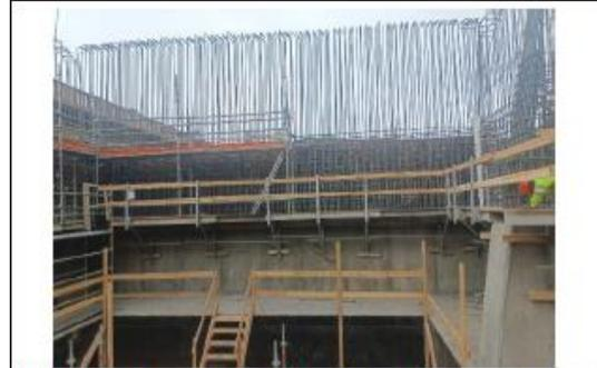
**Ilustración N°2: Armadura Elevación EE Puente Tijeral**
