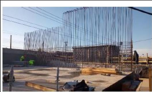
**Ilustración N°1: Fundación Cepa Paso Inferior Las Violetas**
