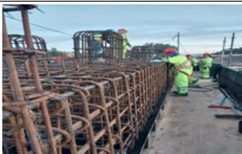
Ilustración N°5: Mesa Apoyo Cepa Paso Inferior Las Perdices
