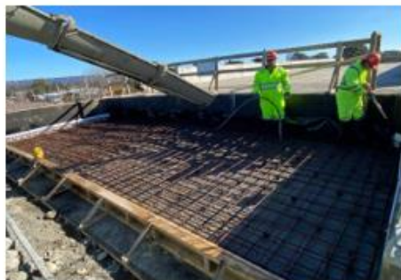
Ilustración N°1: Losa de Acceso Paso Inferior Coihue Estribo de Salida
