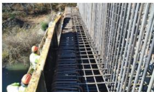
Ilustración N°3: Mesa Apoyo Estribo de Entrada Puente Tijeral Calzada Izquierda
