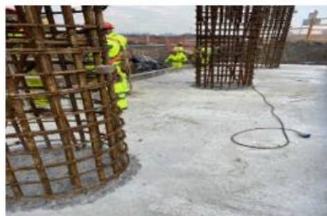
Ilustración N°2: Armadura Elevación Cepa Paso Inferior Ovejera
