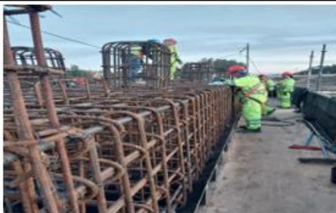
Ilustración N°5: Mesa Apoyo Cepa Paso Inferior Las Perdices
