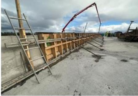
**Ilustración N°1: Estructura Viaducto Coihue Hormigón Defensa tipo F**
