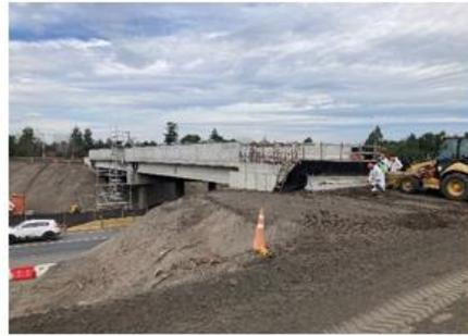
**Ilustración N°2: Losa Acceso Paso Inferior Rinconada**
