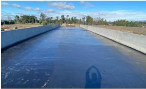
**Ilustración N°3: Membrana de Impermeabilización Losa Tablero Paso Inferior Coihue**
