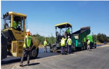
**Ilustración N°5: Colocación Mezcla Asfáltica**
