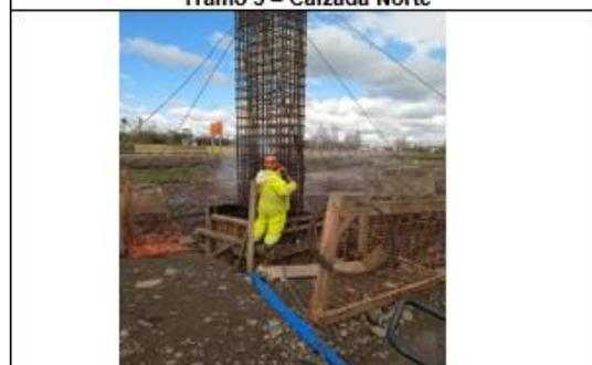
**Ilustración N°4 Armadura Columnas Pasarela **Rihue**.**
