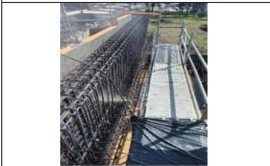
**Ilustración N°3: Armadura Muro Espaldar Estribo Entrada Viaducto Coihue Norte**
