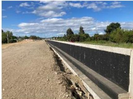
**Ilustración N°6 Muro Cantilever Puente Huequén Calzada Derecha**
