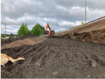
**Ilustración N°1: Terraplén Ampliación Paso Superior Ruta 5**
