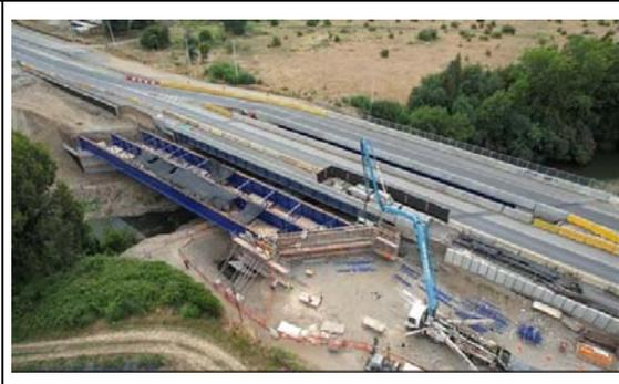
**Ilustración N°6 Vigas Acero Puente Huequén CI**
