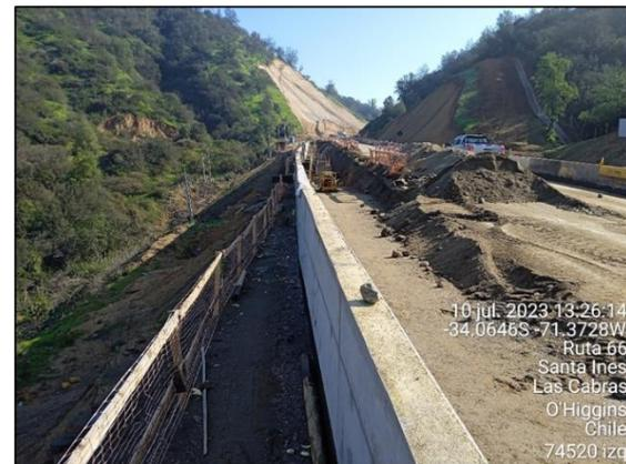
Dm 74.520 Estado del Relleno Muro Cantilever Lado Izquierdo
