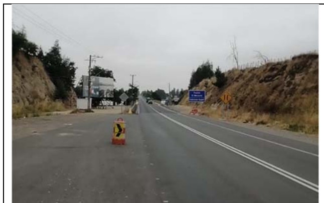
Sector Puente El Durazno, Dm 64.500
