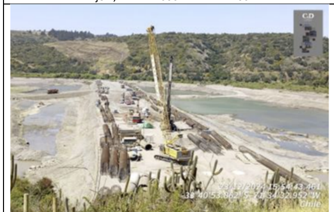
Viaducto Maipo, Dm 125.340 - Dm 125.500
