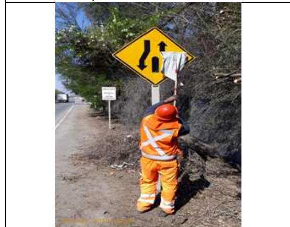
Mantenimiento y conservación de señales verticales
