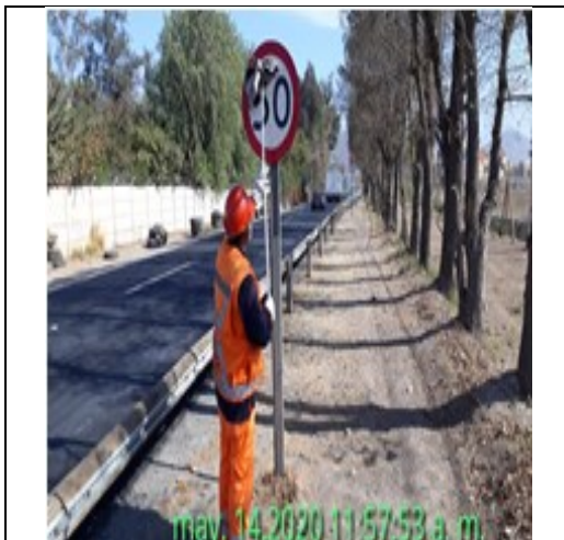
Mantenimiento y conservación de señales verticales
