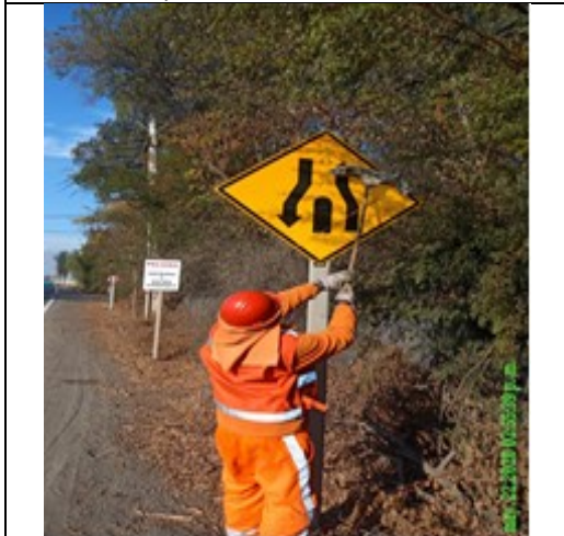
Mantenimiento y conservación de señales verticales
