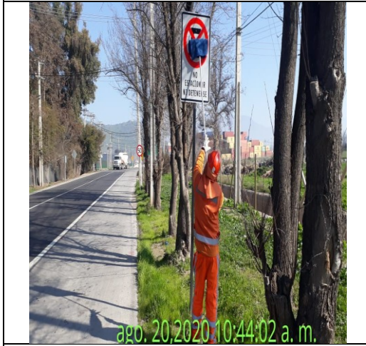
Mantenimiento y conservación de señales verticales
