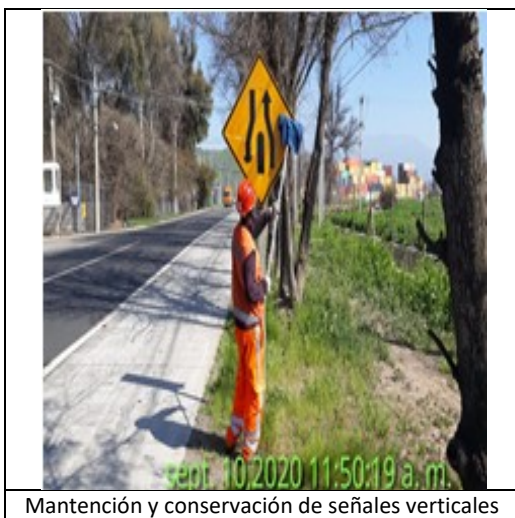
Mantenimiento y conservación de señales verticales
