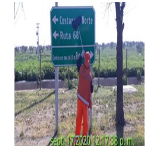
Mantenimiento y conservación de señales verticales
