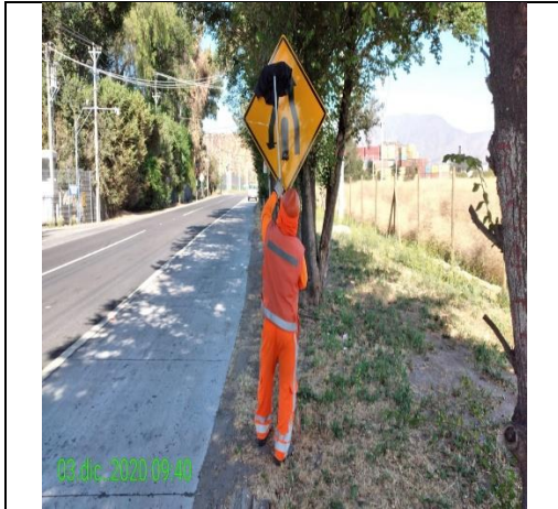
Mantenimiento y conservación de señales verticales
