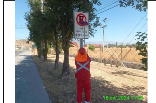
Mantenimiento y conservación de señales verticales
