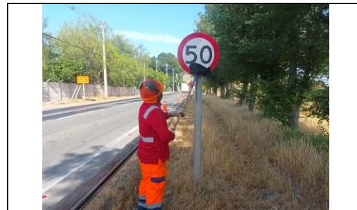
Mantenimiento y conservación de señales verticales
