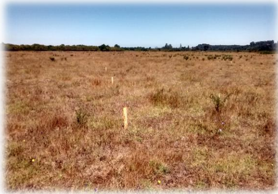
Estacado faja de 40 mts. De ancho, Sector A.
