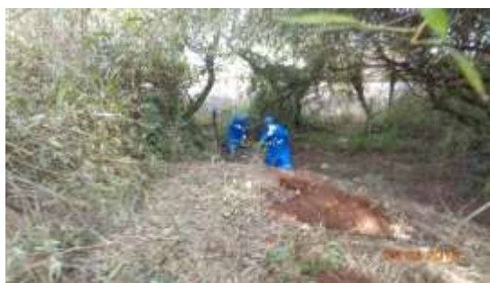
Instalación de cercos perimetrales Faja40 mts. Sector C.
