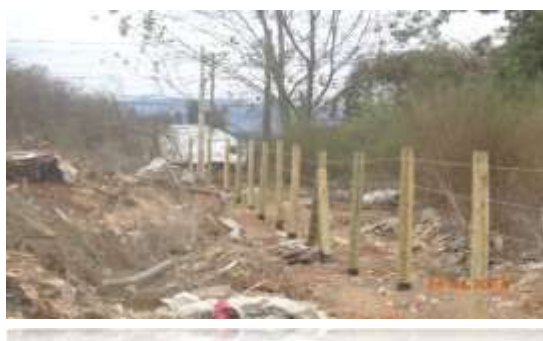
Instalación de cercos perimetrales Faja40 mts. Sector C
