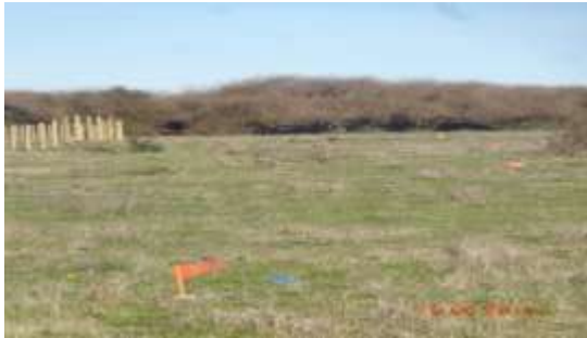
Revisión estacado ensanche de faja 40 mts, Sector A.
