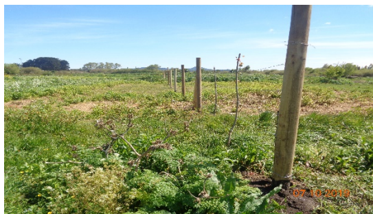
Revisión Instalación Cercos, Sector C.
