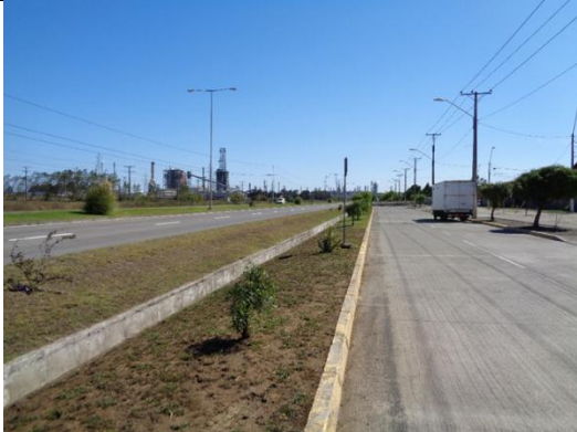
REPLANTEO PASARELA SECTOR A, HUALPEN
