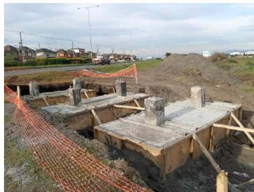
Ejecución de Letrero de Obra, en sector de Hualpén, en etapa de fundación
