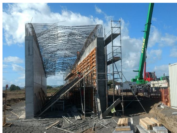
Construcción Paso Ganado
