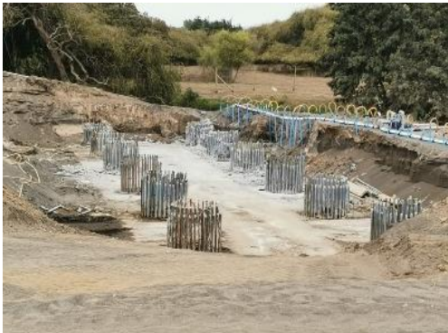
Sector A-Estribo entrada Bocatoma
