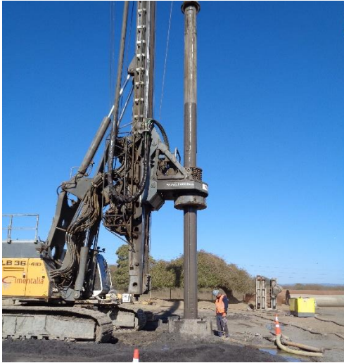
Excavación Pilotes
