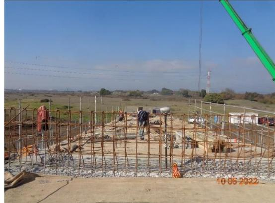
**Estribo de Salida, armadura (Puente Bocatoma)**
