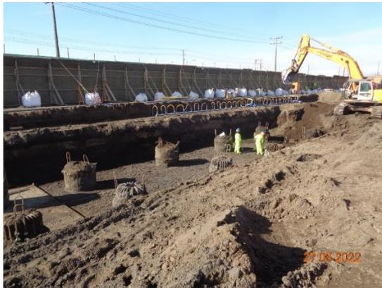
**Moldajes, para losa superior de paso Ganado**
