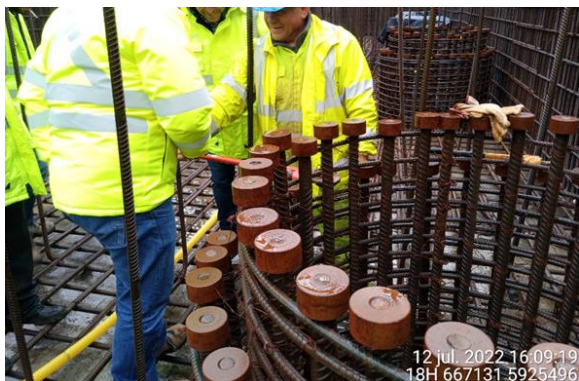
Proceso torque Lenton 32 mm - Pte. Industrial
